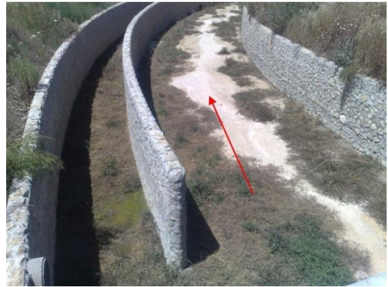
Figura 8 - Manufatto (la freccia rossa indica l'innesto del diversivo)
